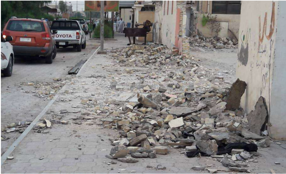
صور (9) انقاض البناء في مينة الخضر
